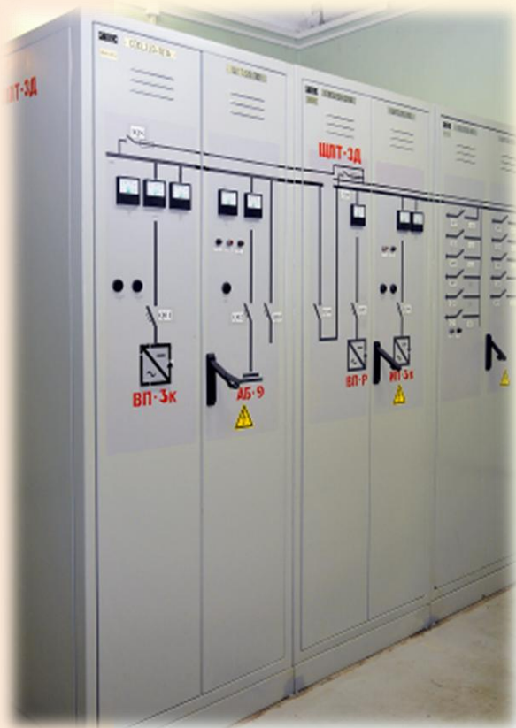
DC switchboard SchPT-3D
