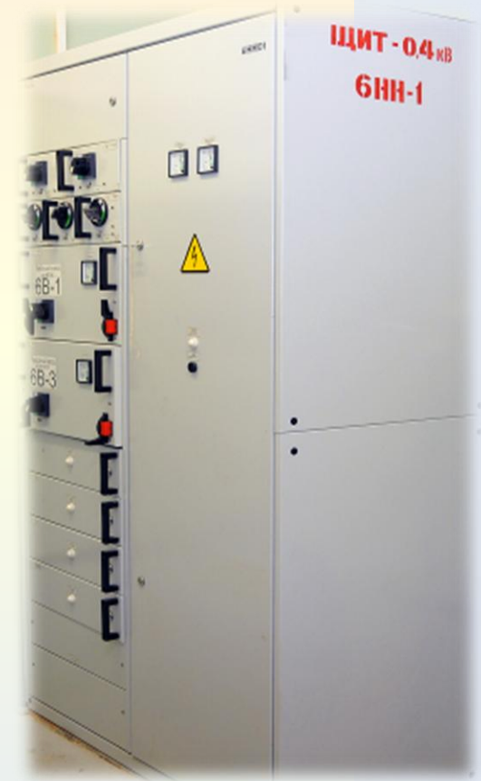
Switchgear 0.4 kV 6NN-1
