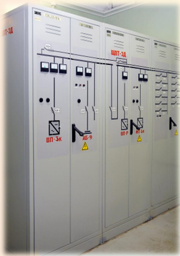
Щит постоянного тока ЩПТ-3Д
