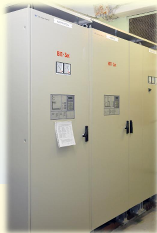
Распределительное устройство 0,4 кВ 6НН-1
