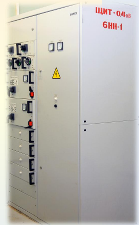
Распределительное устройство 0,4 кВ 6НН-1
