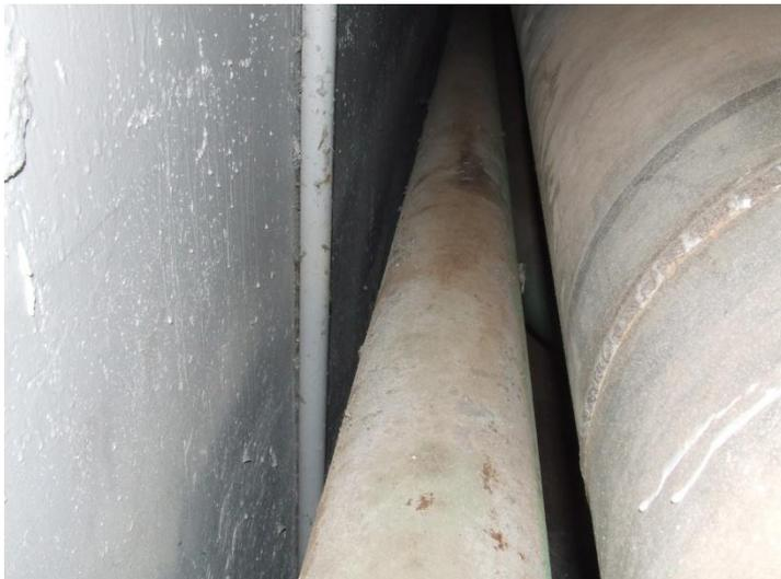
Мешает близкое расположение СС с трубопроводом меньшего диаметра
